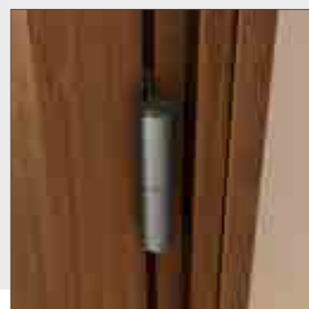
Στιβαρός μεντεσές στήριξης κάσας 100kg.
