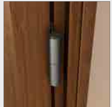
Στιβαρός μεντεσές στήριξης κάσας 100kg.
